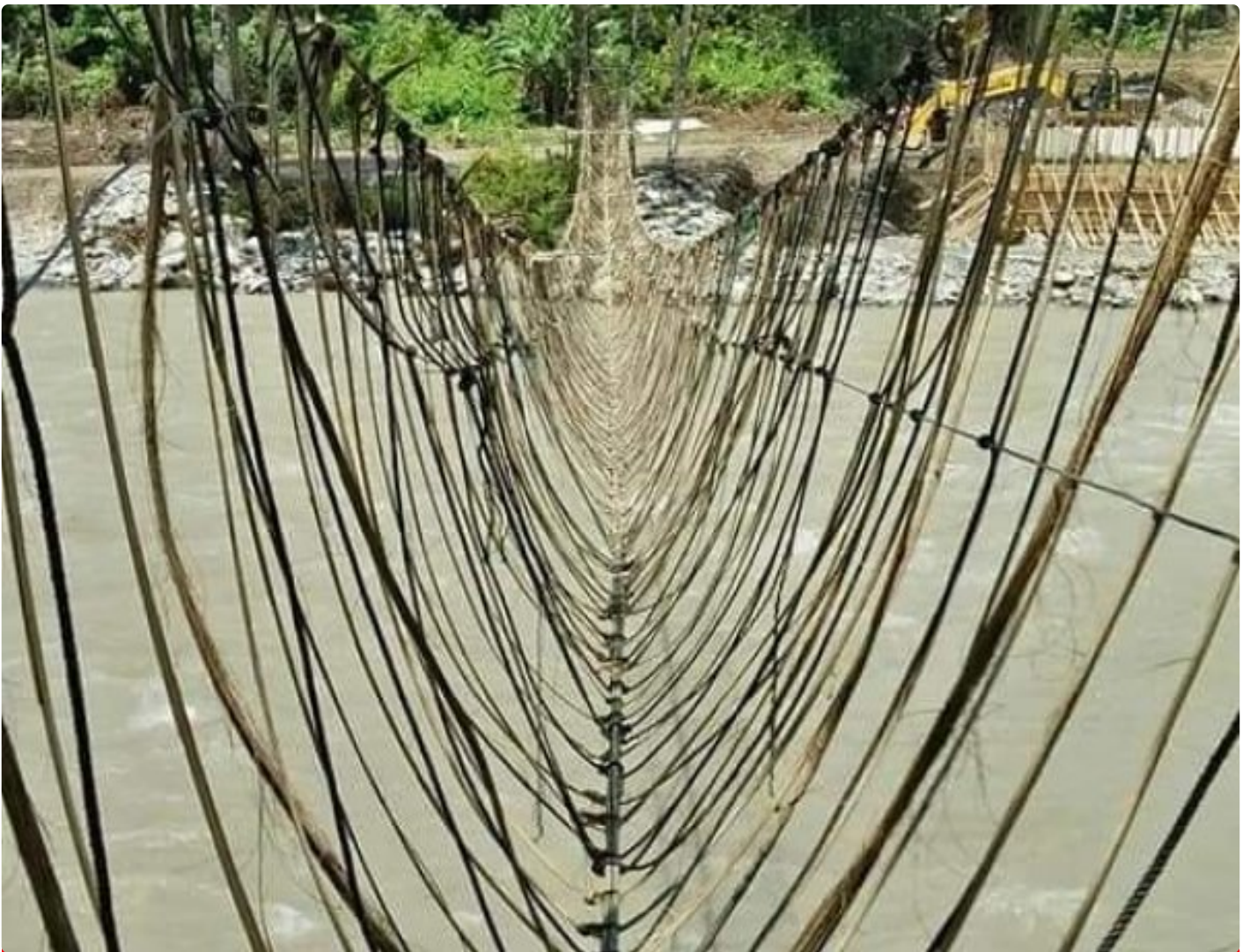
Jembatan sungai Digoel, sebelum kejadian.
